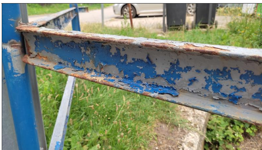
Detail oprýkaný náter na zábradlí.jpg
