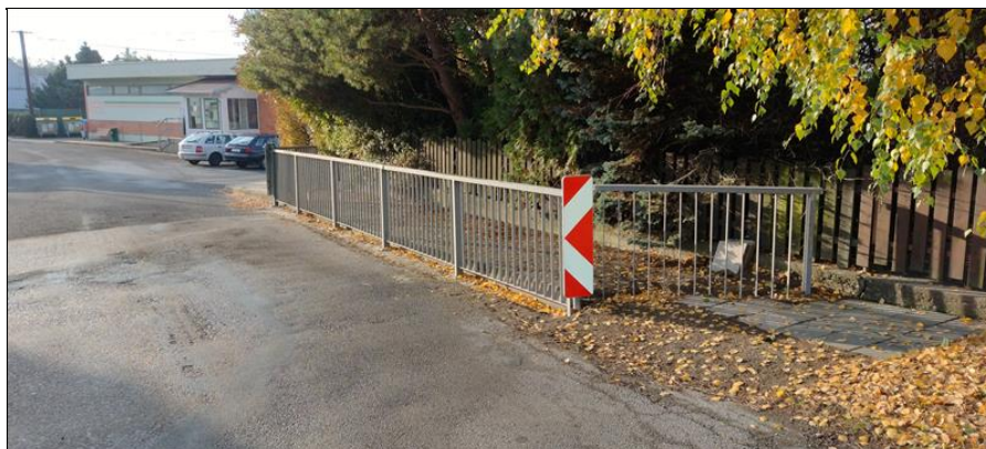
Celkový pohled na most po směru staničení po dokončení HMP. Doplněné zábradlí, nad částí chodníku v havarijním stavu.
