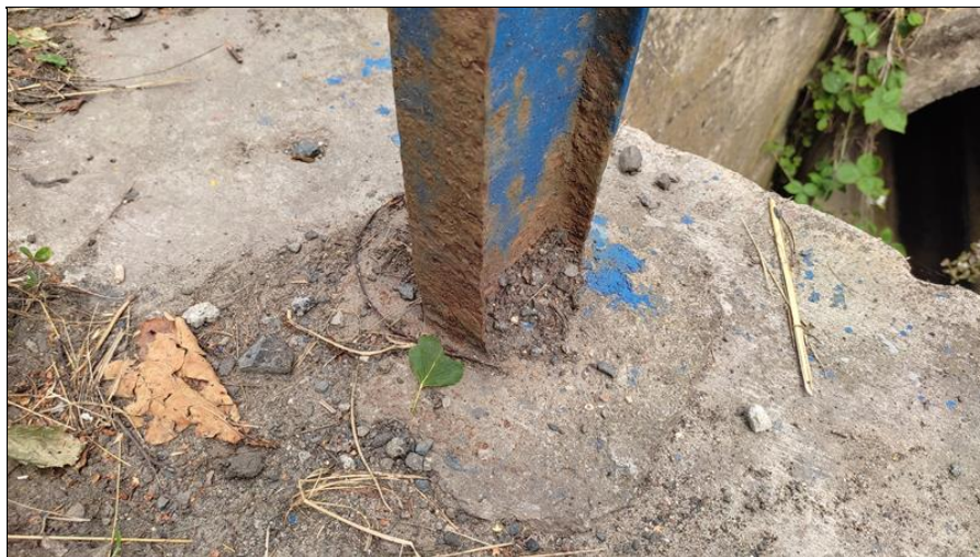
Detail koroze sloupku zábradlí.jpg
