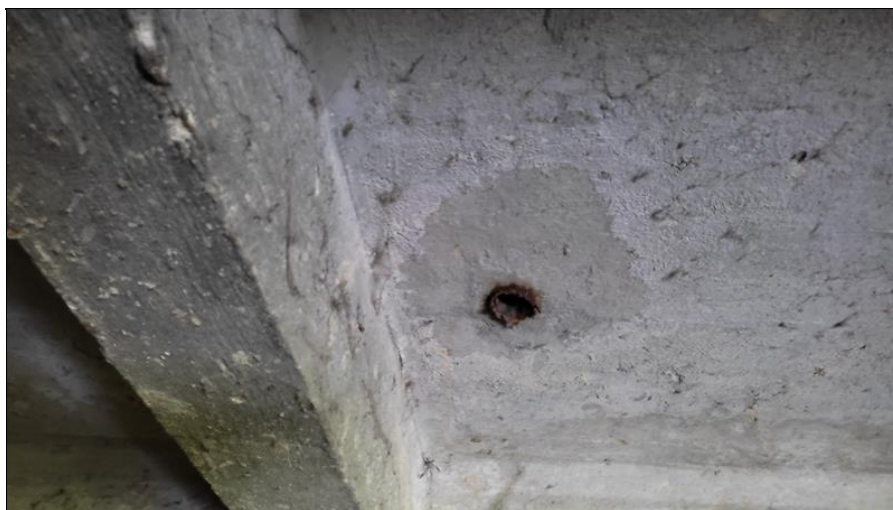
Detail korodující trubičky odvodňovače.jpg
