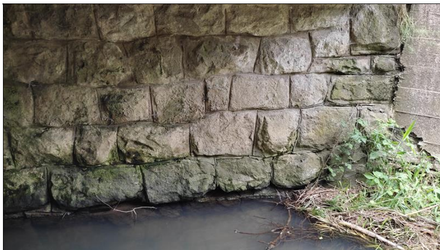
Detail v úrovni hladiny vydrolené zdívo.jpg
