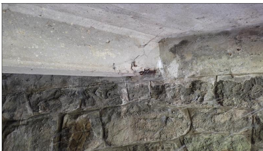
Detail korodující výtuže na ŽB trámu.jpg
