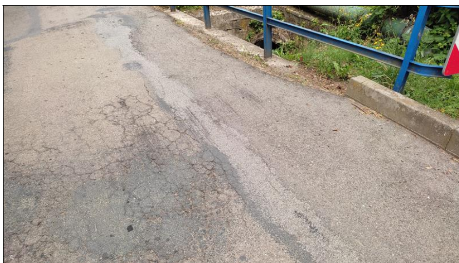
Detail všesměrné trhliny krajnice.jpg
